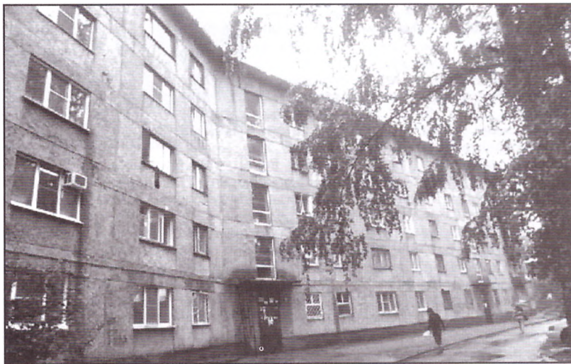
Жилой дом на ул. Буркацкого в Центральном районе
